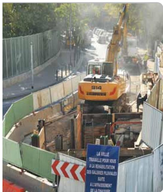
Pour l'essentiel, ces travaux consistent en une réfection totale des réseaux dits « humides », c'est-à-dire l'eau potable, l'assainissement et le pluvial
